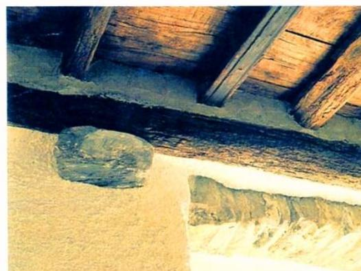
le parti rovinate sono state riparate con stucco a solvente (elastico e resistente ai cambi di temperatura); per finire, è stato passato l'impregnante color noce, opaco.
